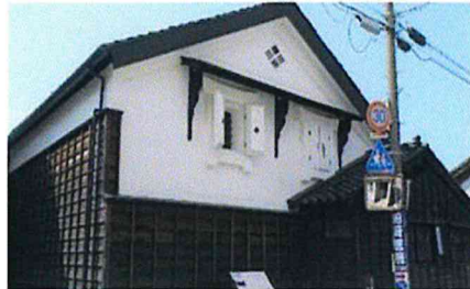
百年の蔵 (旧十二銀行 米倉) 魚津の米騒動のシンボルとされる大正生まれの蔵。県内 現存する米騒動関連、唯一の建築物。今も現役の倉庫。
